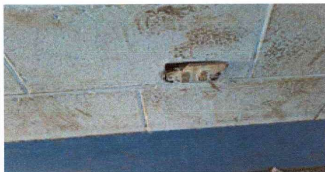
Foto 1: pintura en muros exteriores e interiores y reparación de sistema eléctrico
