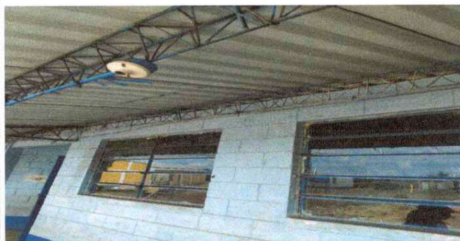
Foto 2: Mantenimiento a estructura de soporte de metal
