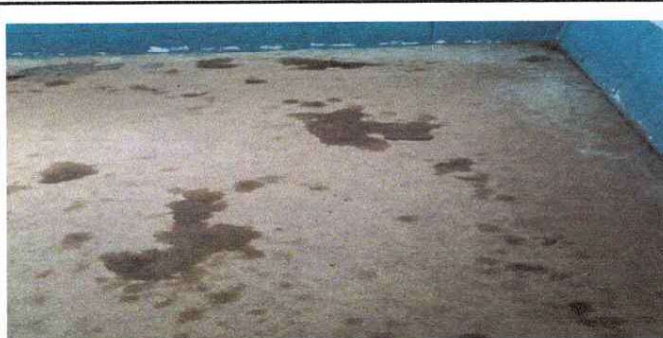
Foto 5: Sustitución de piso concreto por granito y ceramico
