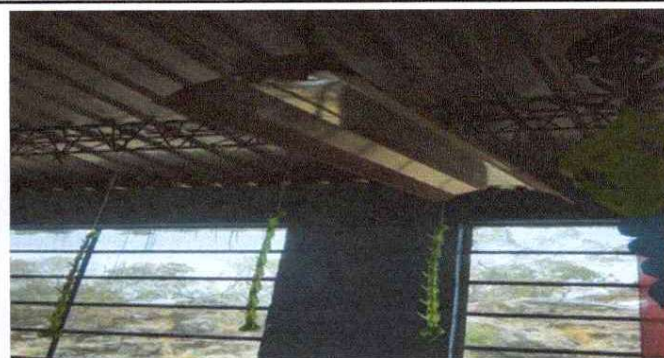
Foto 2: reparación de sistema eléctrico lámparas tipo led
