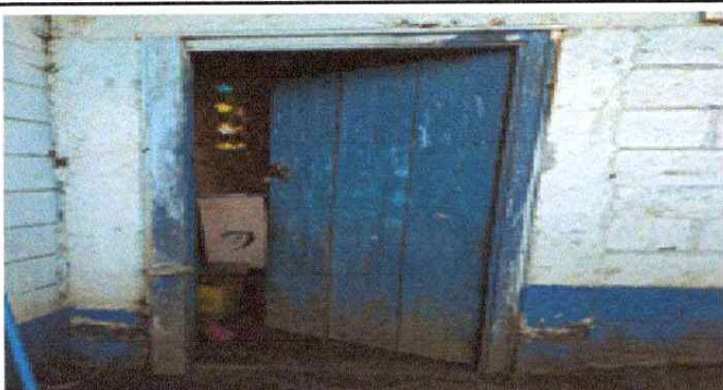
Foto 3: Sustitución de puertas
