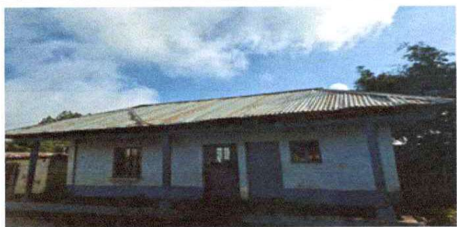
Foto1: Sustitución de lámina acanalada por lámina troquelada aluzinc calibre 26 en cocina y módulo
