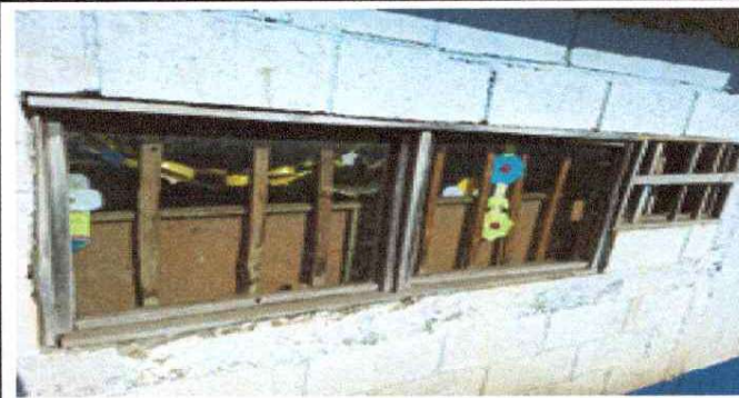
Foto 4: Sustitucion de ventana de madera por metal más vidrio
